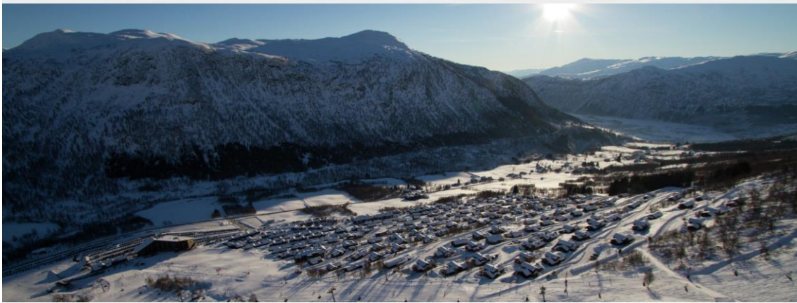
Figur 41: Myrkdalen fjellandsby. Hotell i nedre venstre hjørne, det største fritidsboligområdet i midten av bildet. Heisanlegg i nedre kant av bildet.
